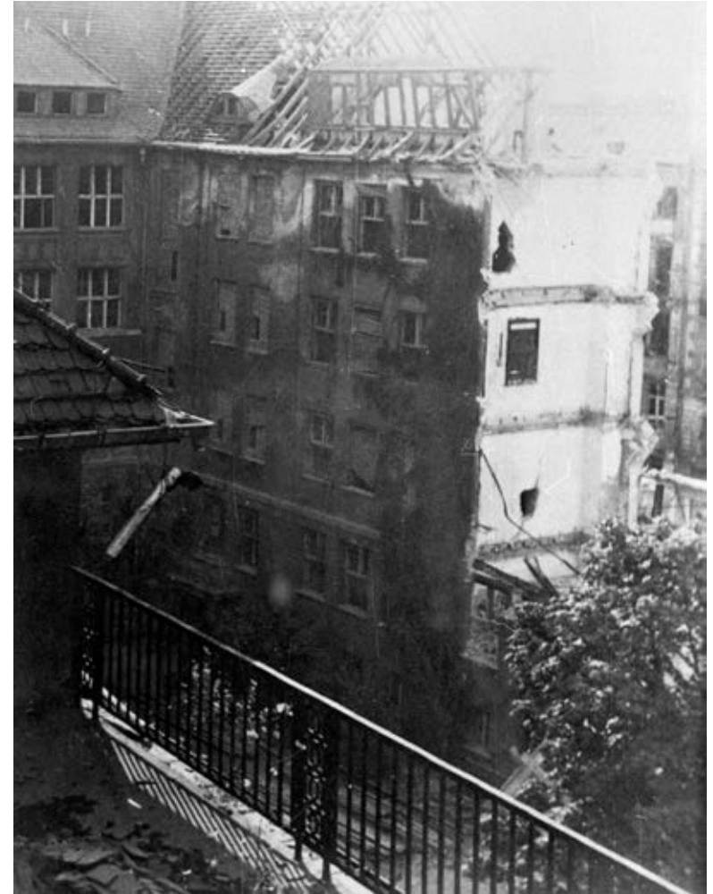
↑ Auf dem Bild sieht man den Schulhof der Staatlichen Augusta-Schule (bzw. ab Dezember 1945 der Sophie-Scholl-Oberschule), die durch Bomben zerstört wurde. Hier sieht man, dass das Dach komplett ausgebrannt ist und die unteren Stockwerke zerstört sind.
